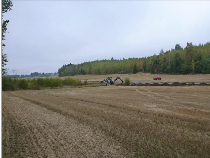
Kaivanto kuvattu itään. Kivikautinen asuinpaikka on loivalla rinteellä kaivannon takana.
