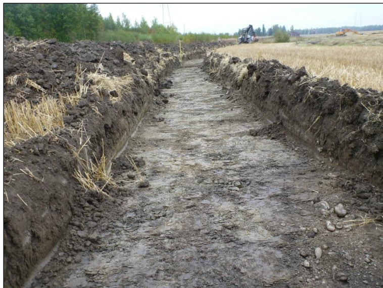
Kaivettua kaivantoa, savinen pohjamaa näkyvissä.
