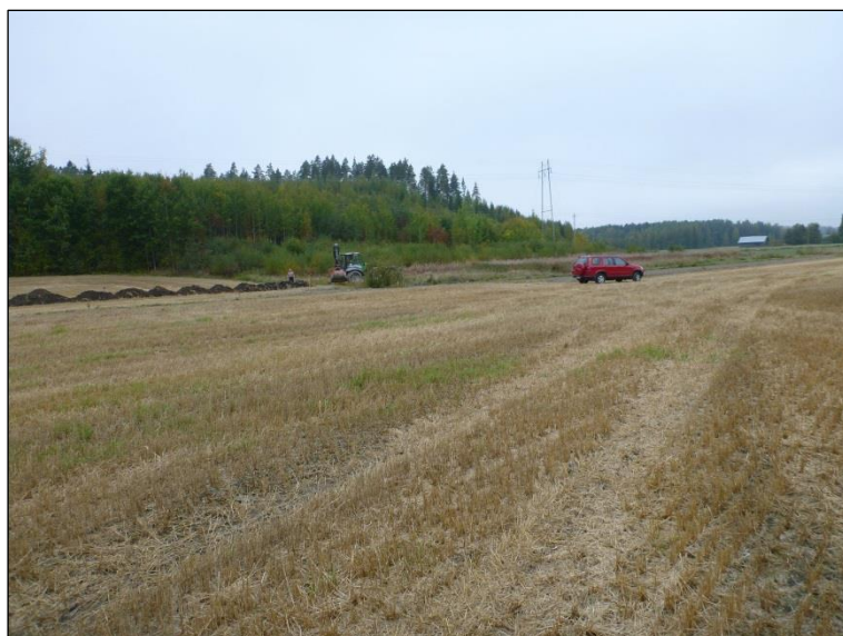
Kaivantoa kuvattuna länteen.
