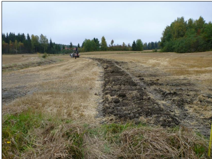
Täytettyä kaivantoa kuvattuna itään.
